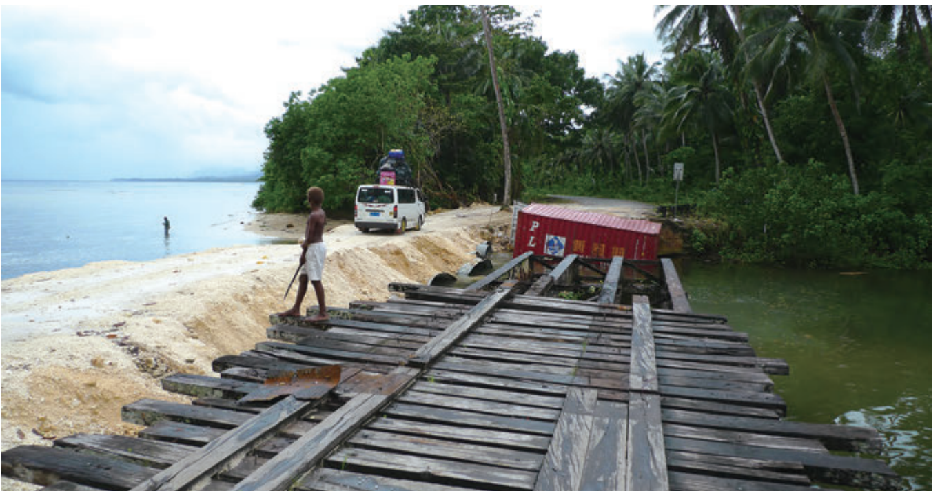
▲盛り土の上に見えるのが私たちのワゴン車、右手が崩壊した橋
