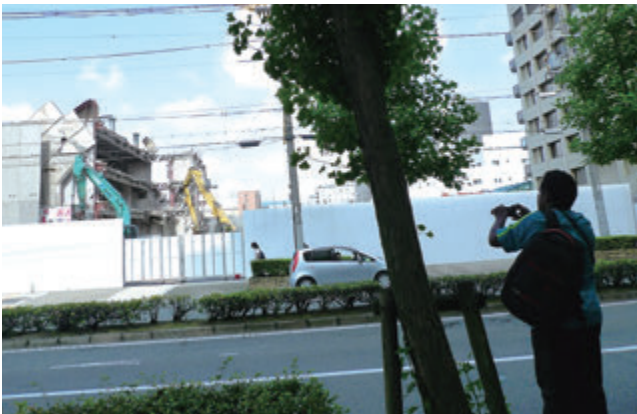
▲コンクリートパネル（合板）にセメントを注ぐ工事現場の写真を撮るポールさん
