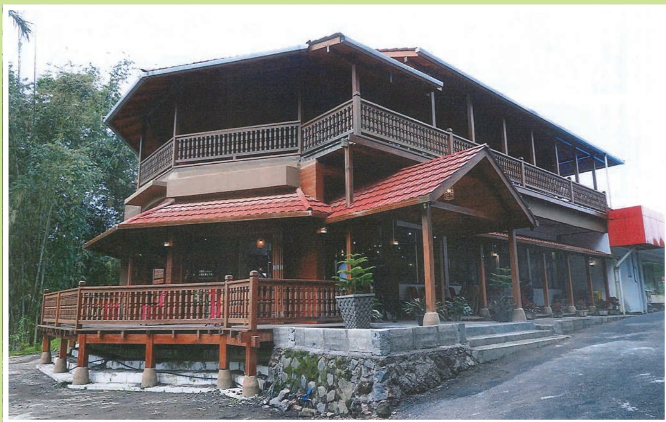
地元の材、地元の伝統技術で完成したインドネシア初の「道の駅」（森を守る会代表の辻垣正彦による設計）
