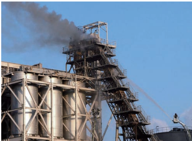
火災を起こした北九州の木質バイオマス発電所 出典：西日本新聞WEBサイト2020年10月13日 ( https://www.nishinippon.co.jp/item/n/653795/ )
