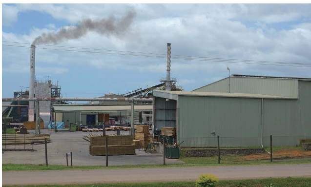
フィジー・パイン社の製材とチップ製造工場
