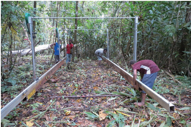
ポール・パボロさんたちの木材事業の現場で—— 移動式製材機のレールを敷く
