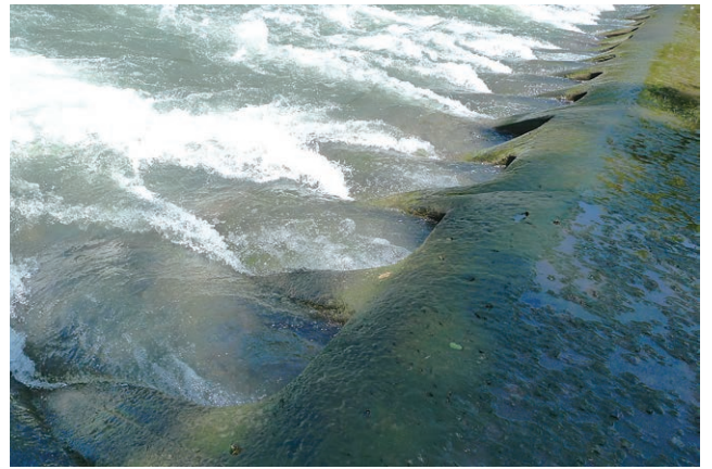
▲オープンベイ・ティンバー社の建設した“サブマリン橋”
