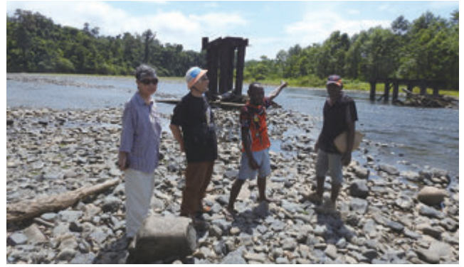
アニア川の壊れた橋
