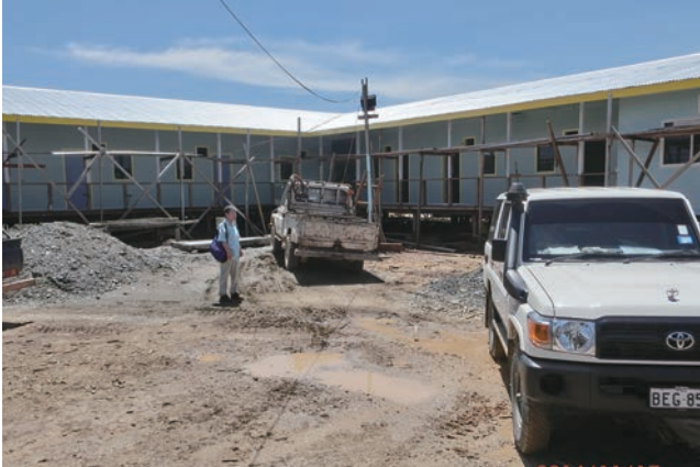
操業一時停止命令に違反して、ボス用の宿舎のセメント工事が進行中だった
